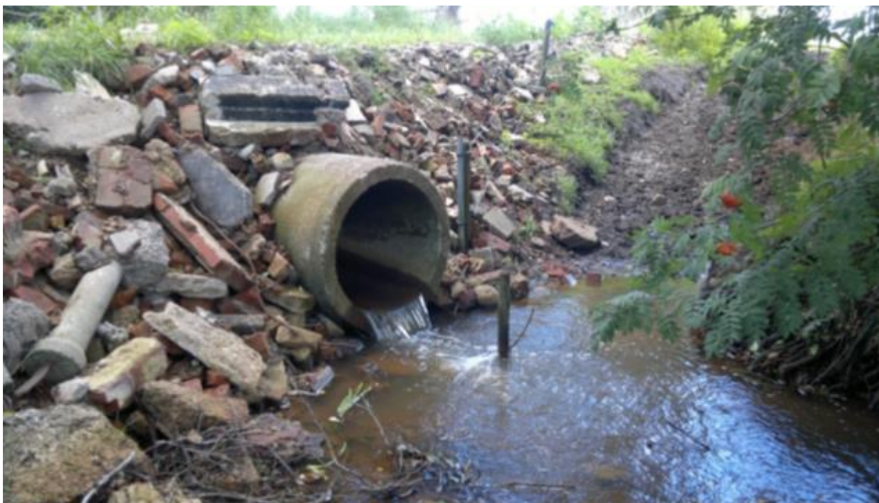
Billede 1b. Rørbrø som det så ud før omlægning.
