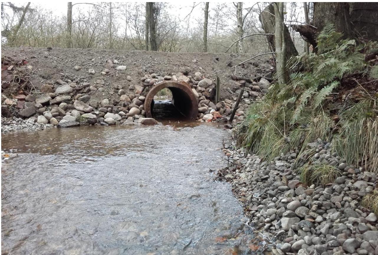
Billede 1a. Udløb af omlagt rørbrø og udlagt grusstryg.
