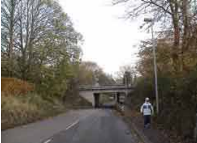
Hornevej - kig mod Viadukt
