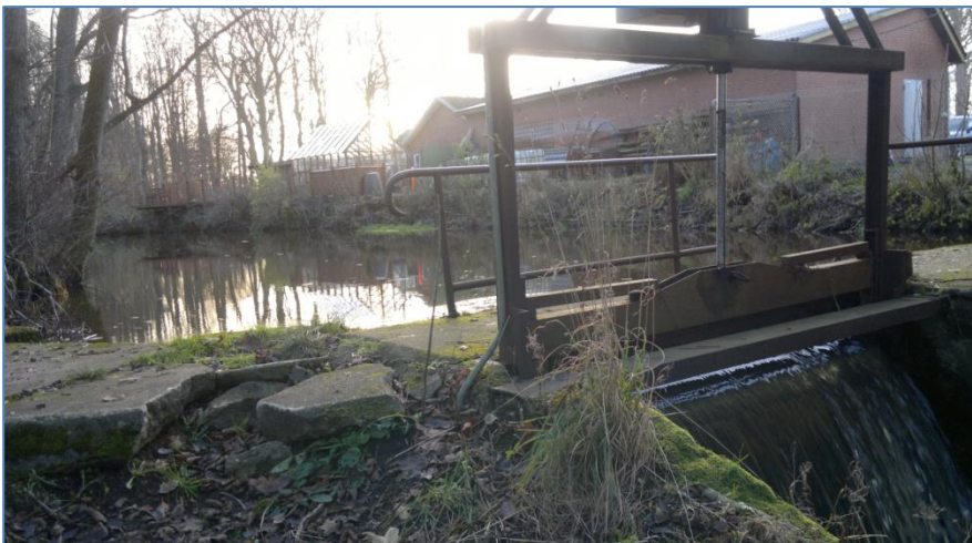
Fig. 3. Det er ikke muligt at komme til stemmeværket med entreprenørmaskiner fra sydsiden af Ansager Å.
