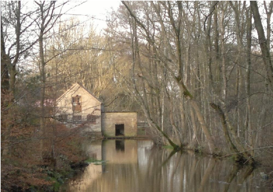
Fig. 2. Stemmeværket blev oprindeligt anlagt til et vandkraftværk. Turbinerne sad under den lave tilbygning. Her kan manuelt fjernes stemmeplanker foran huset i forbindelse med større afstrømninger. Det motoriserede, men ikke automatiske stemmeværk, er umiddelbart til højre for turbinehuset.
