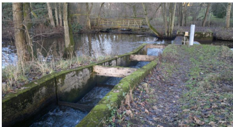
Fig. 7. Fisketrapp ved udløbskanalen fra dambruget.
