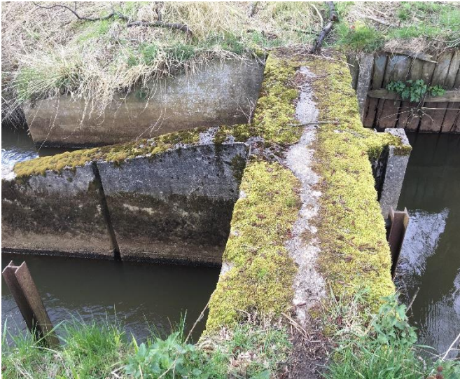
Figur 25. Gammelt stemmeværk i st. 9.785.
