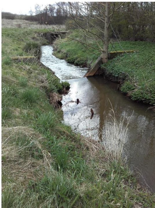
Figur 20. Styrt ved st. 7.083.
