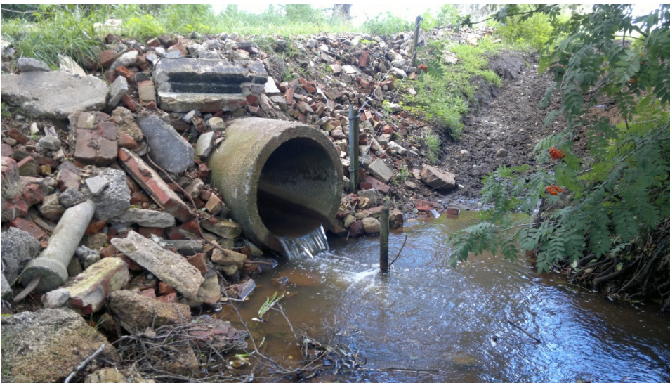
Figur 3. Ved udløbet var der d. 13. juni 2013 et spring på ca. 9 cm fra bunden af røret til vandspejlet i Mariebæk.
