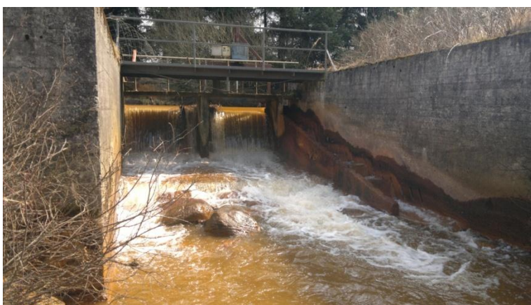
Fig. 4. Det eksisterende stemmeværk er et stort solidt bygværk med et vandslug på ca. 4,2 m og ca. 0,8 m til en fisketrappe. Vandets okkerbelastning er tydelig.
