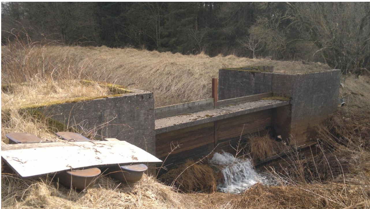
Fig. 10. Udløbsbygværk fra bagkanalen. Vandet løb direkte i Skonager Lilleå herfra, før der blev stillet krav om rensning af vandet ved bundfældning.
