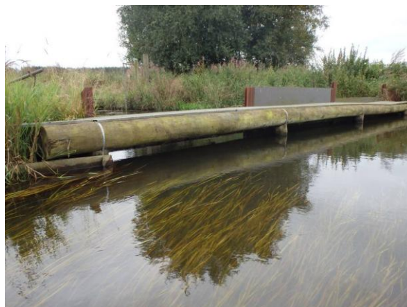
Figur 48: Uafgitret afløb fra Krogager Dambrug.
