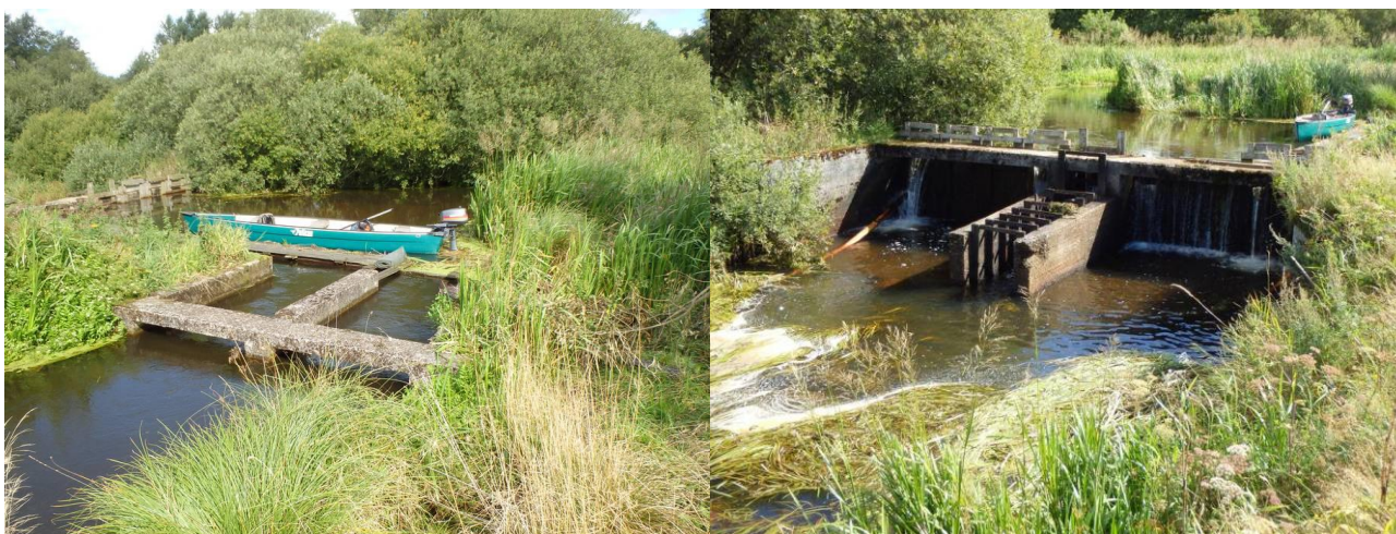
Figur 72: Stemmeværk og uafgitret vandindtag ved Hesselho Dambrug.
