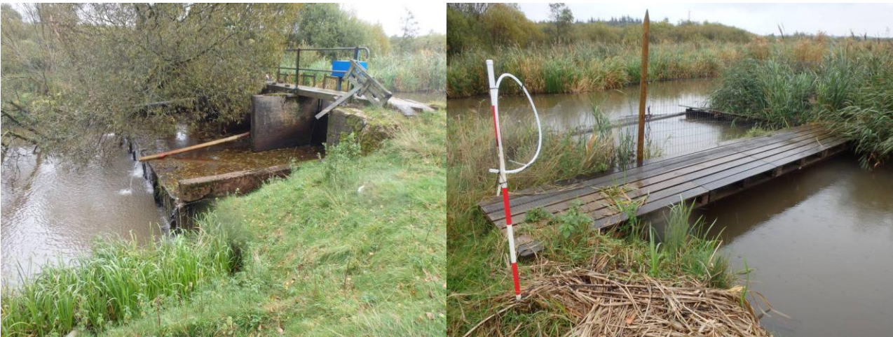
Figur 91: Stemmeværk ved Alslev Mølle Dambrug (t.v.) og vandindtag (t.h.).
