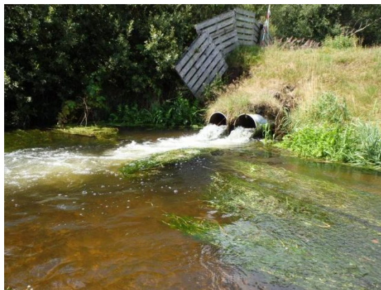
Figur 68: Uafgitrede rørudløb fra dambrug H28.
