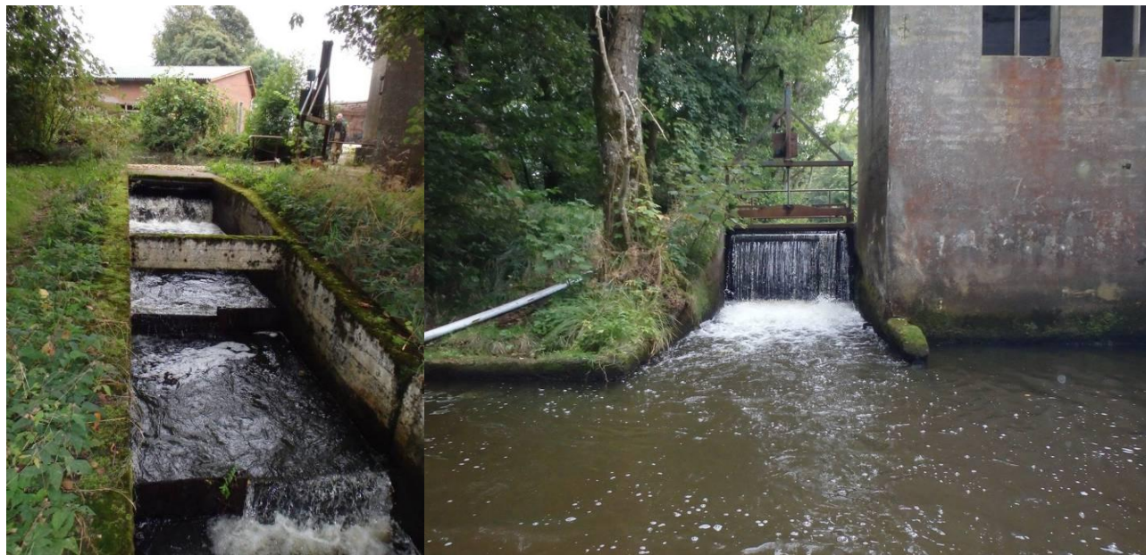
Figur 50: Stemmeværket ved Ansager Mølle t.h. og kammerfisketrappen t.v.
