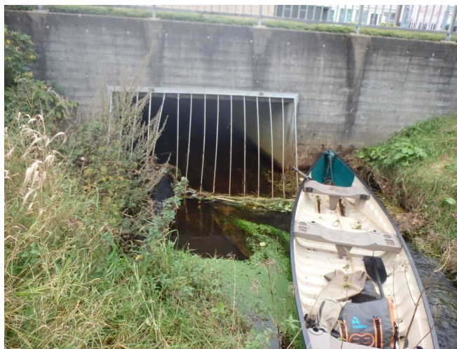
Figur 32: Afgitteret indløb til rørlagt strækning i Billund By.
