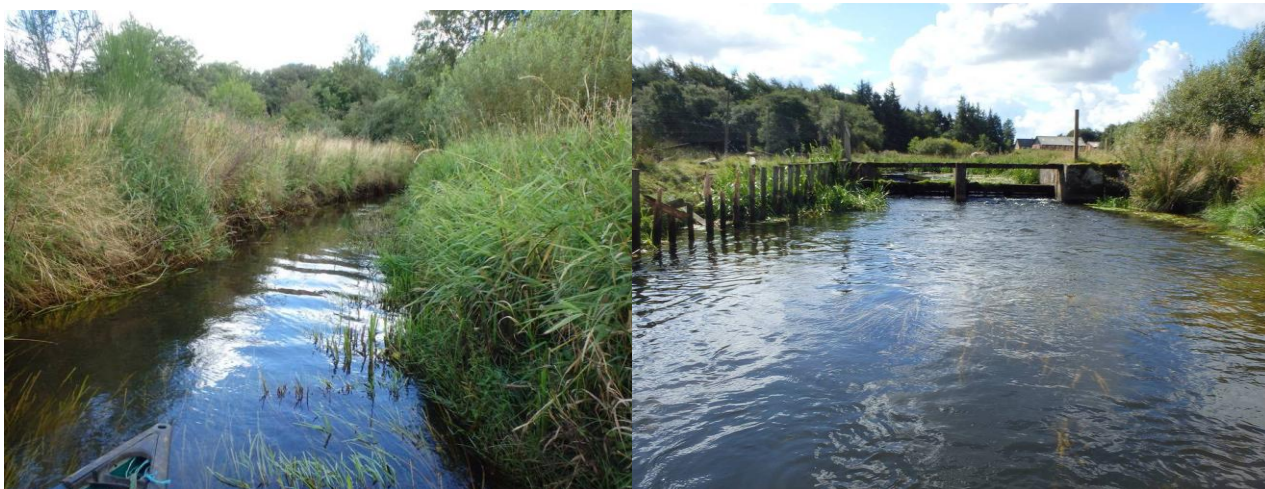
Figur 73: "Død" åstrækning og udløb ved Hesselho Dambrug H68.
