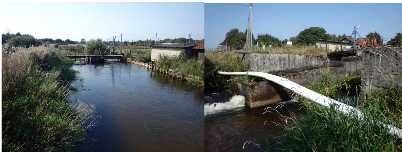
Figur 22: Opstrøms (t.v.) og nedstrøms stemmeværket ved Utoft Dambrug.
