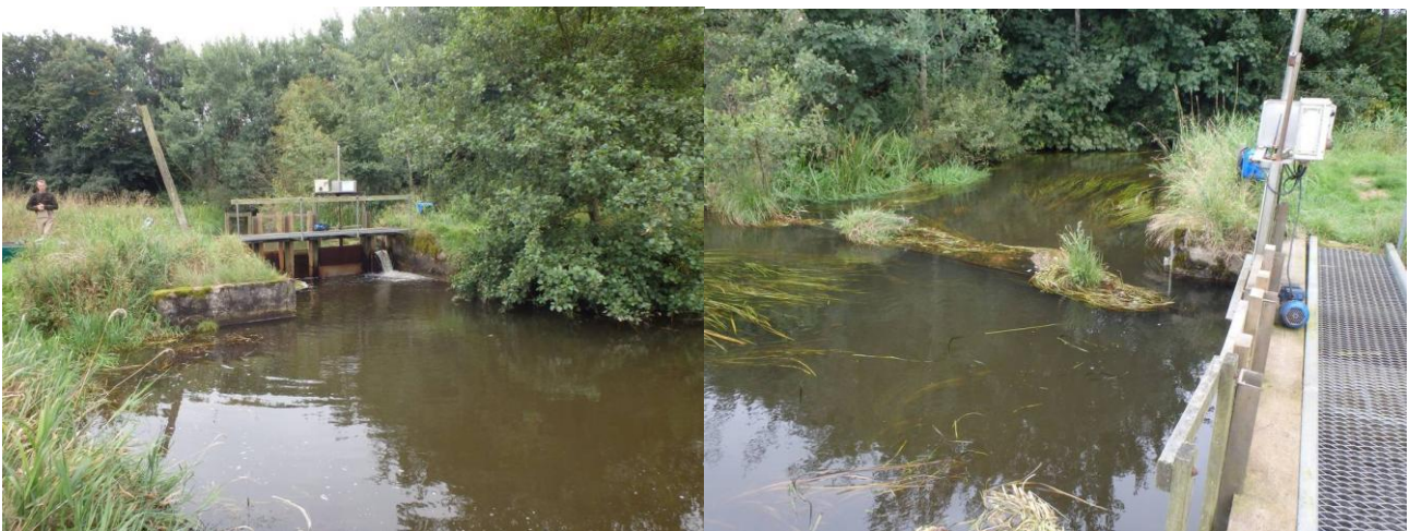
Figur 47: Stemmeværk og vandindtag ved Krogager Dambrug.
