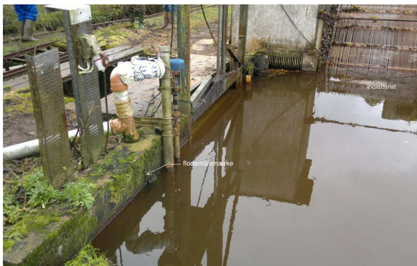
Fig. 3. Flodemålsmærket - kote 22,05 DNN ~ 21,95 m DVR90 - sidder i venstre side af stemmeværket. Ifølge dambruget er der en hensigtsmæssig drift af dambruget med en vandstand på 8-10 cm under flodemålsmærket.
