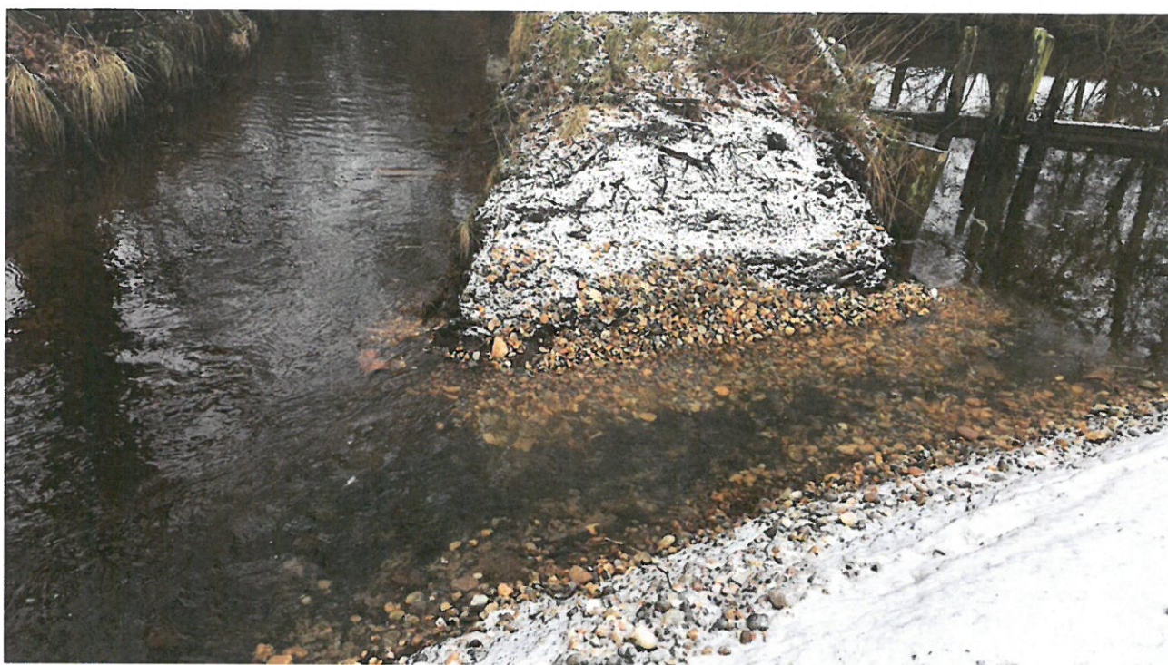
Figur 5. Vestterp-Haltrups Bæk's ny sammenløb med Grønrose Bæk. Nedstrøms ende af det ny omløbsstryg th.
