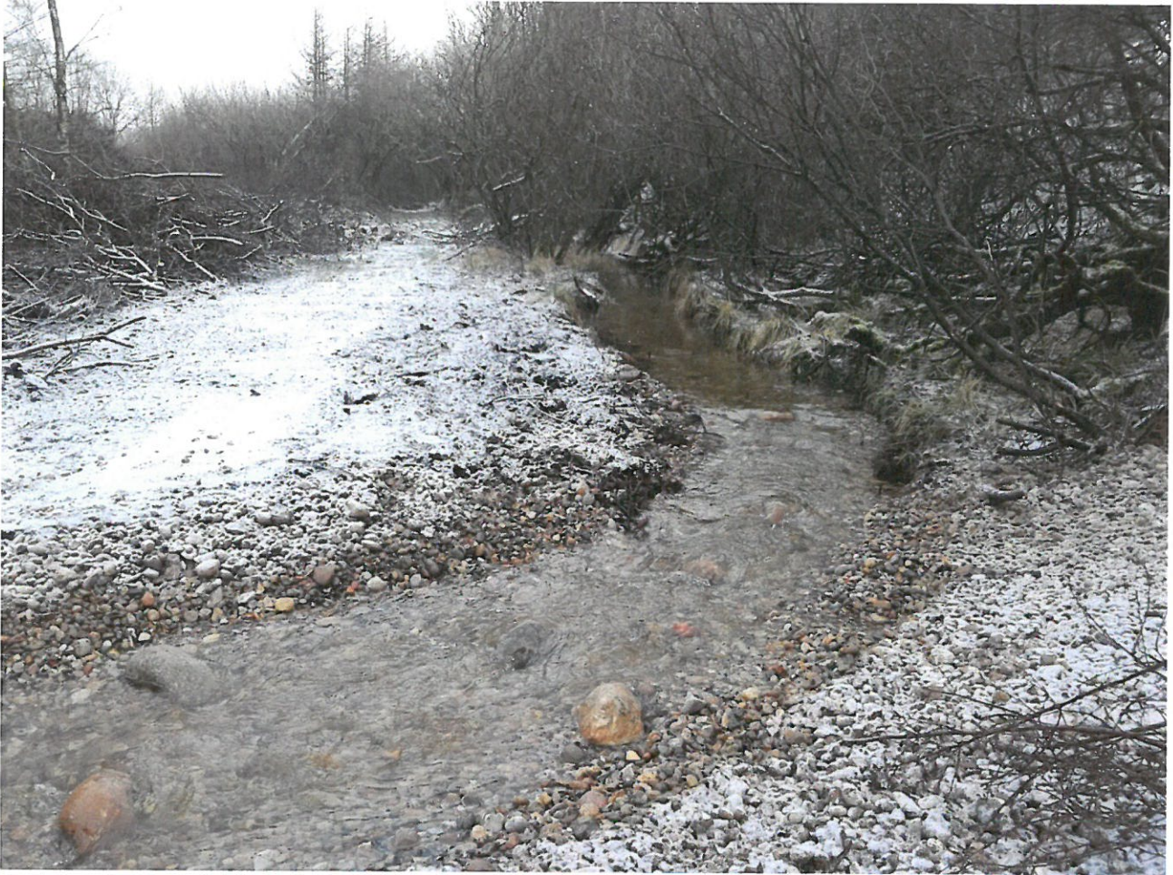
Figur 8. Øverste del af stryget hvor Vestterp Haltrup Bæk og den tidligere fødekanal er afskåret og ført ind i det nye omløbsstryg.
