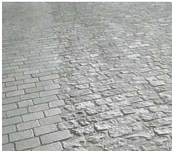
Eksempel på passage med glatte sten i en traditionel brostensbelægning.
