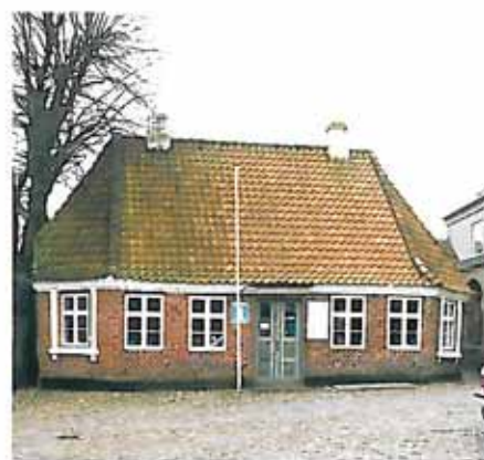
Sillasens Hus, Torvet 5. Symmetrisk facade med skrå hjørneafskæring.
