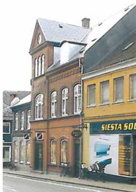
Storegade 27. Asymmetrisk facade, hvor asymmetrien understreges ved gavlkvistpartiets fremspring fra facadeplanet.
