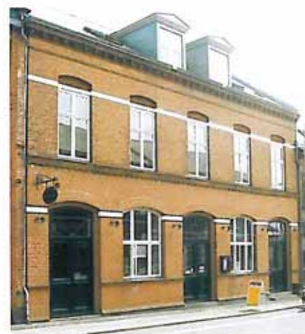
Torvegade 3 efter facaderenovering.
