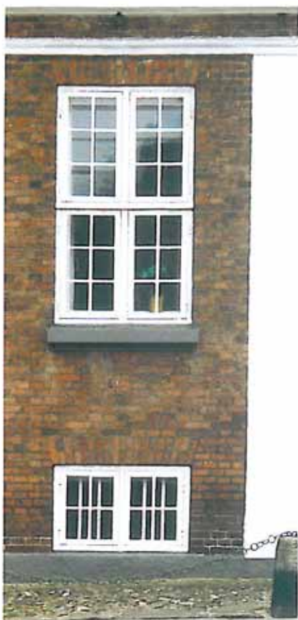
Korspostvindue med seksrudedede rammer. Bemærk at ruderne i under- og overrammer er lige store.
