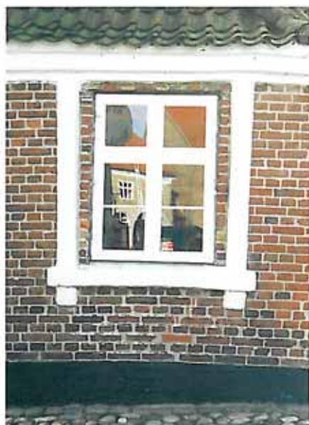
Korspostvindue med enrudede overrammer og torudede underrammer. Bemærk at ruderne i under- og overrammer er lige store.
