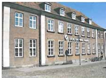
I bankbygningen fra 1929 på Torvets nordside inddeler flade, pudsede murpiller facaden i et syvfags midterparti og tofags sidepartier. Midterpartiet fremhæves af bl.a. vinduesindfatninger og tagkviste. Hovedindgangen var oprindeligt i midterfaget.
