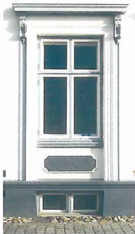
Torammet vindue med uopdelte rammer (Dannebrogsvindue).
