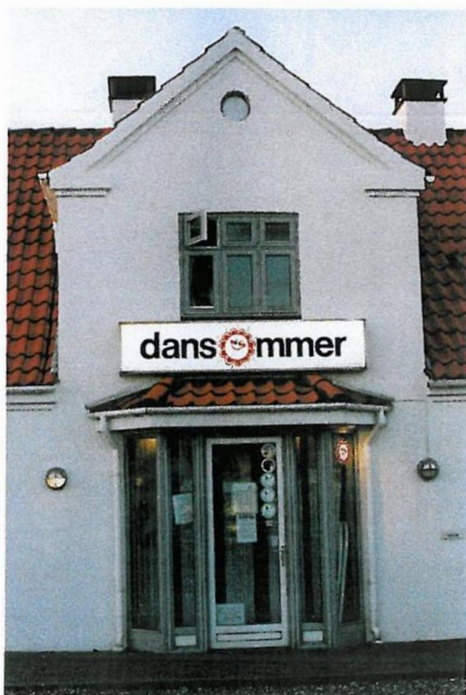
Lyskiltet er flot i aftenlys, men om dagen virker lyskassen meget tung på facaden
