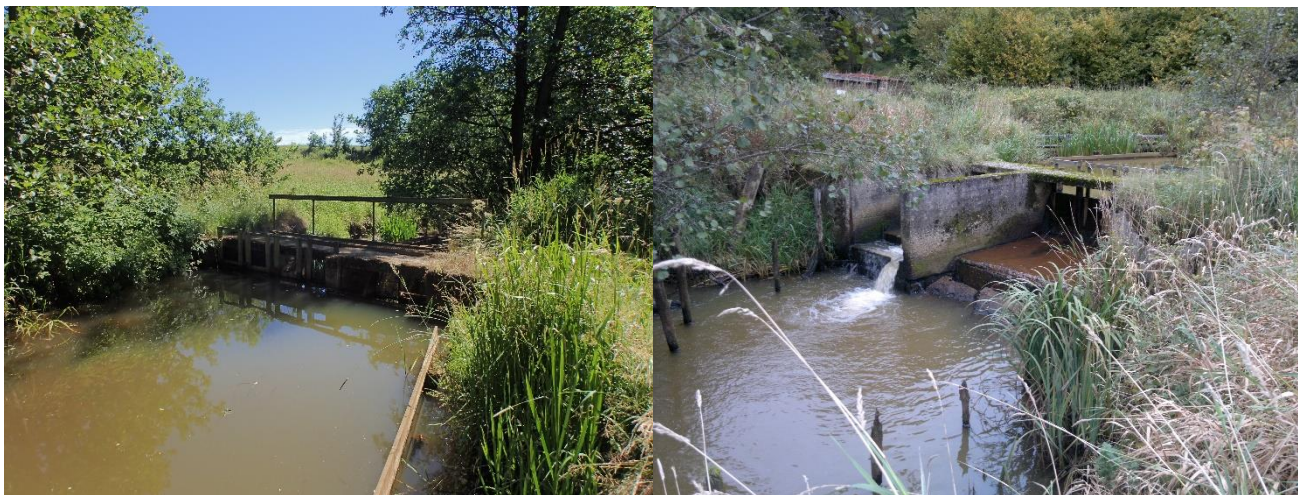
Figur 2. Stemmeværket set hhv. opstrøms og nedstrøms.
