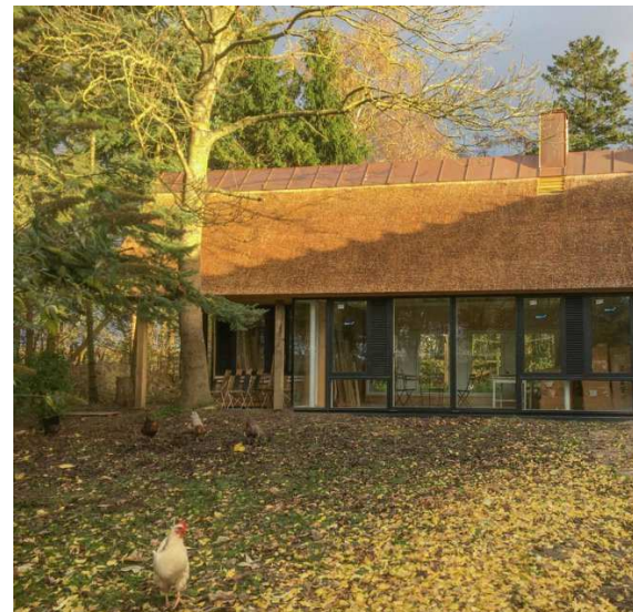
Figur 21 Eksempel på rygning på et stråtag, som er udført i mat kobberfarvet metal.
