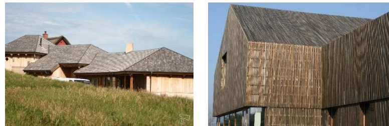
Figur 22: Eks. på hhv. træspån og trælister som tagbeklædning.
