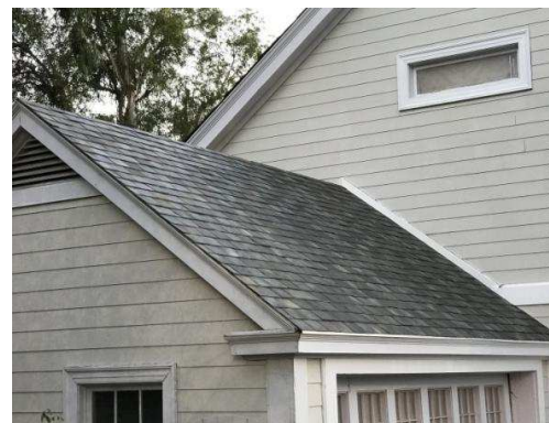
Figur 23 Eksempel på, hvordan solceller kan være fuldt integreret og indbygget i tagmaterialet. www.ing.dk
