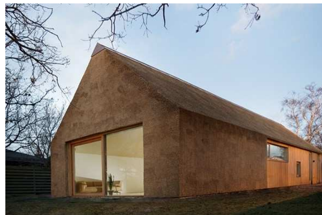
Figur 13 Eksempel hvordan strå kan blive brugt som facadebeklædning i kombination med træ.
