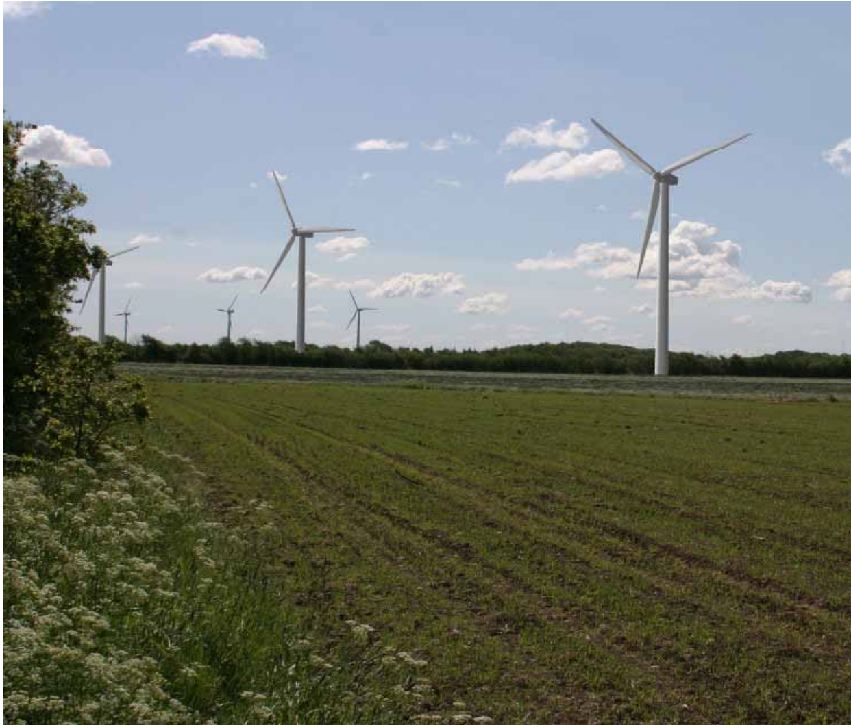
Foto 1. Billedet viser 3 nye 850 kW-møller i forgrunden og de 3 eksisterende møller ved Bovnum i baggrunden. Billedet illustrerer samtidigt, at forskellene på de gamle og de nye møller (maks. 4 m i navhøjde og maks. 8 m i rotordiameter) er vanskelige at få øje på, fordi møllerne står så langt fra hinanden som ca. 800 m.
