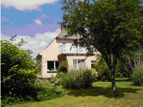
Havevej 2, som er i en dårlig stand, påtænkes nedrevet.
