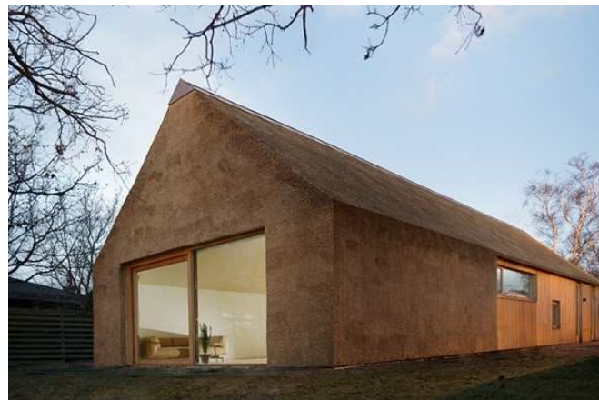
Figur 14 Eksempel hvordan strå kan blive brugt som facadebeklædning i kombination med træ.
