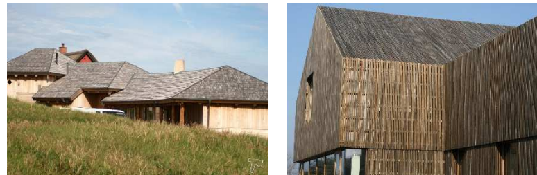
Figur 23: Eks. på hhv. træspån og trælister som tagbeklædning.
