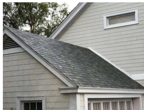
Figur 24 Eksempel på, hvordan solceller kan være fuldt integreret og indbygget i tagmaterialet. www.ing.dk
