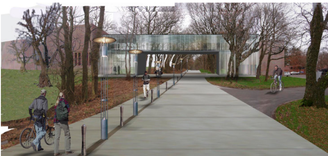
Byggeri over Frisvadvej
