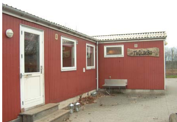
En af den eksisterende børnehaves tilbygninger
