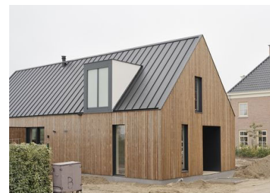
Eksempel på tag med stålplader
