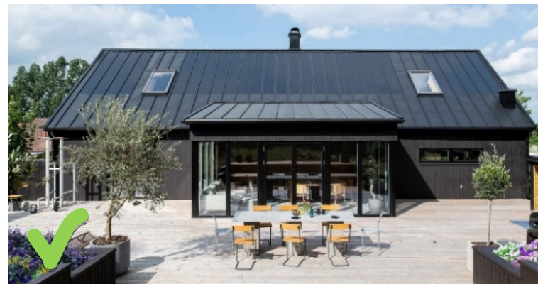
Eksempel på hvordan solceller kan være fuldt integreret og indbygget i tagmaterialet
