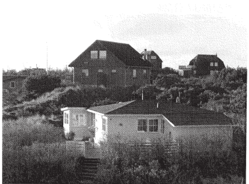
Figur 4: Ternevej 9 er et typisk funkishus fra 1937 (foto nr. 3).
