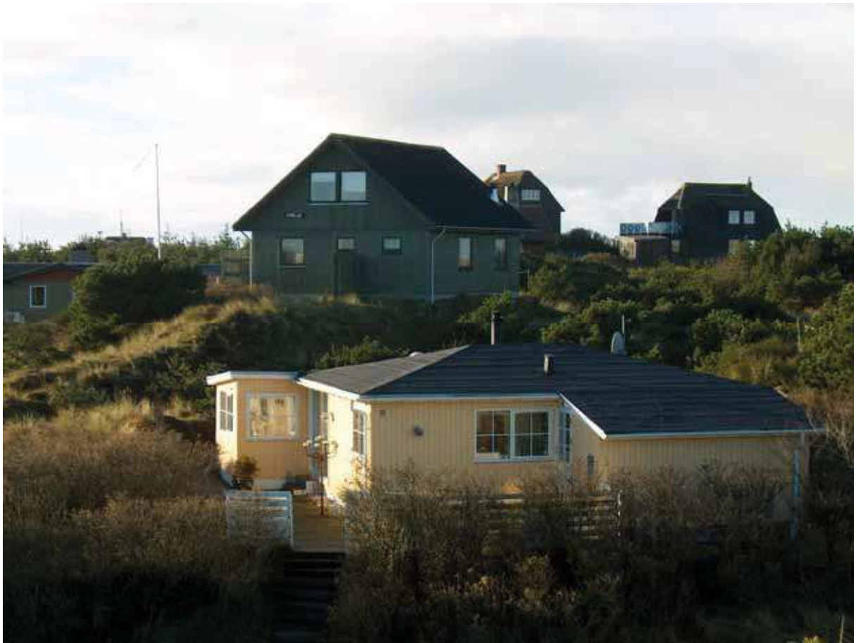
Foto nr. 3. Huset set fra klittop nord for Ternevej.
