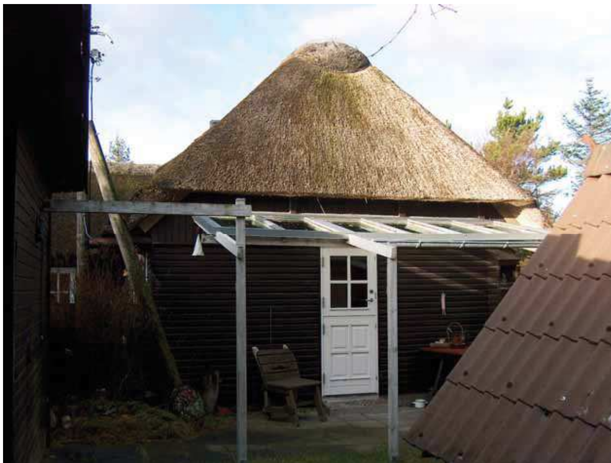
Foto nr. 24. Hovedhusets østgavl set fra gårdspladsen. Som det fremgår, er stråtaget forholdsvis nyt.
