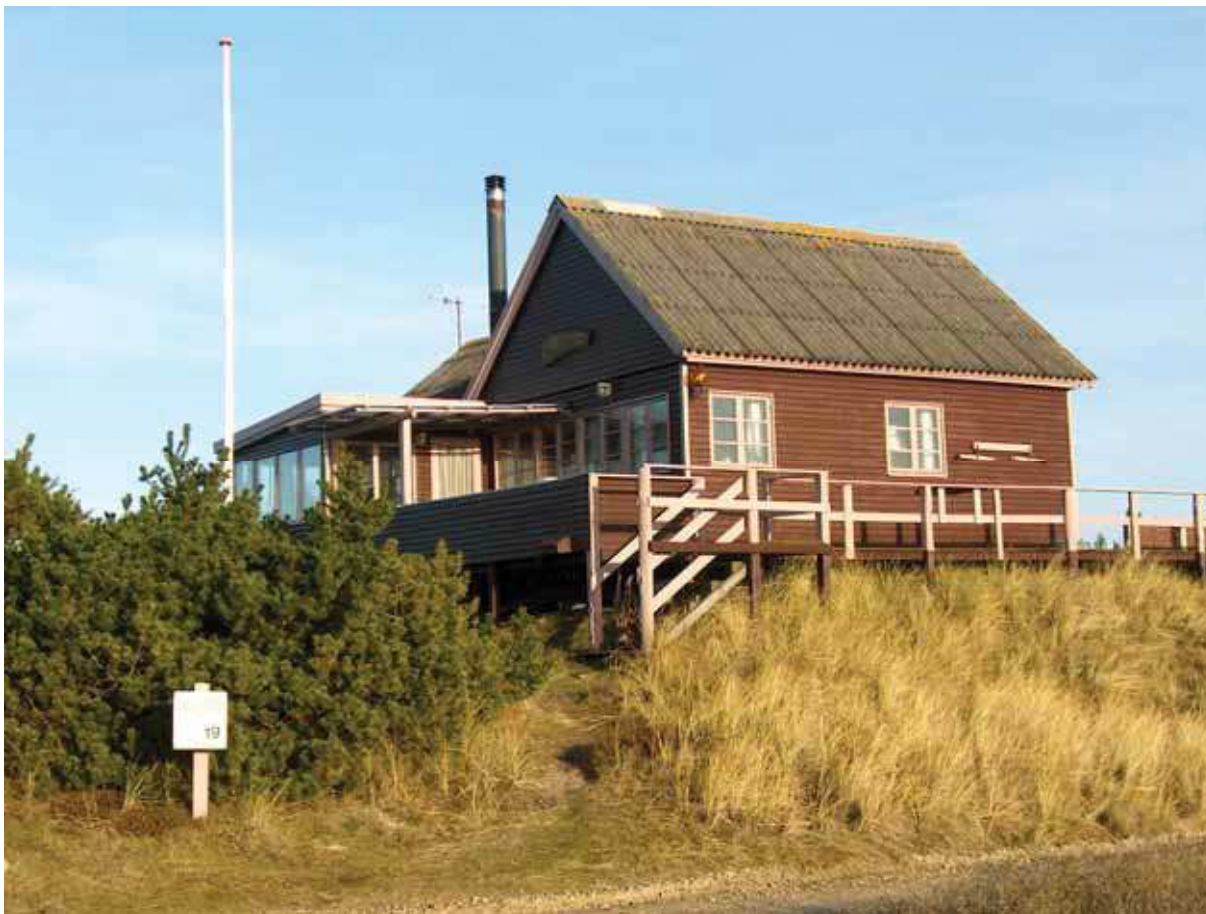
Foto nr. 63. Set fra Mågevej.
