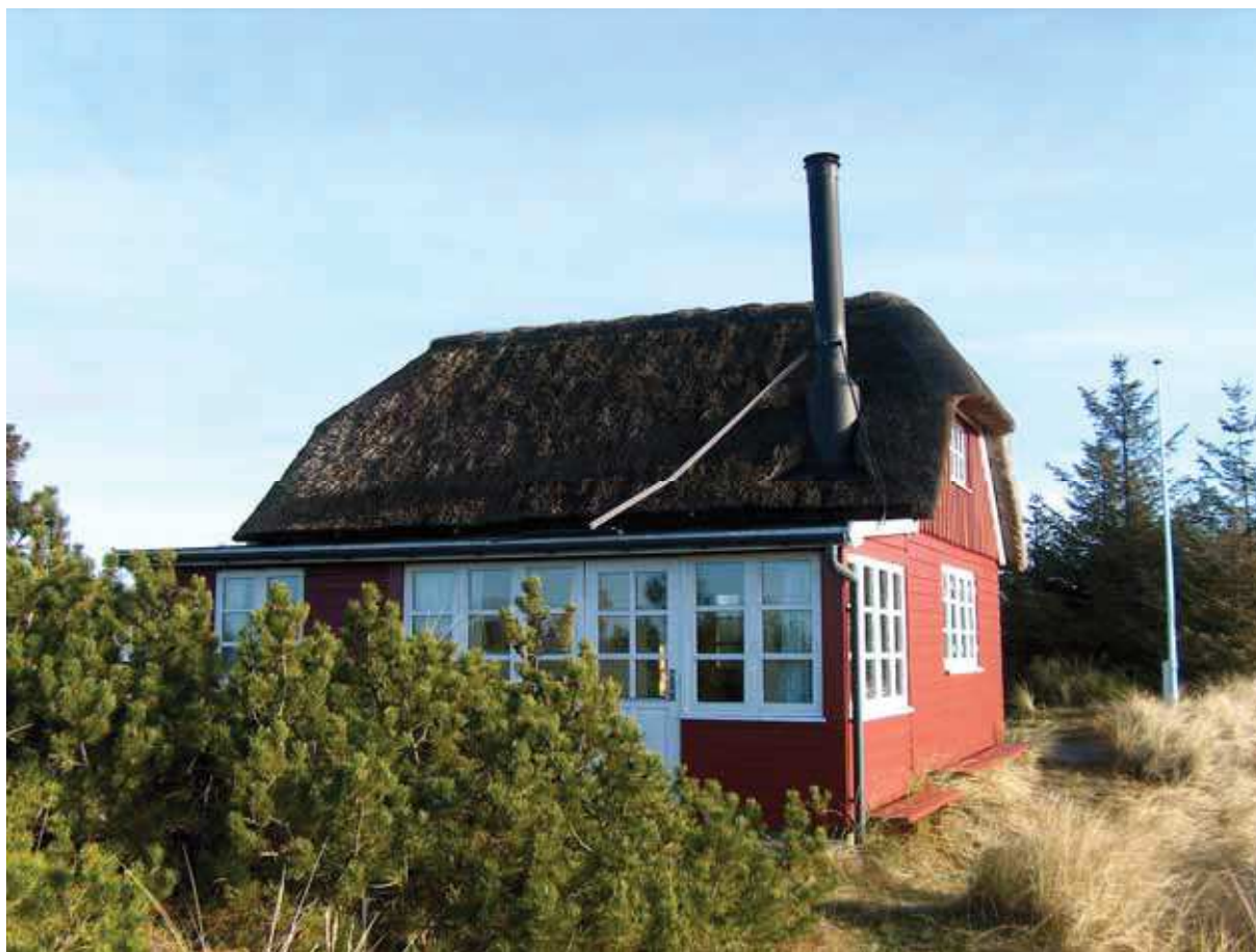
Foto nr. 53. Fra vest ses udskuddet med de store småsprossede glaspartier. Bemærk stålskorstenens kraftige forankring, det sikrer dens opadstræbende rejsning selv i stormvejr.
