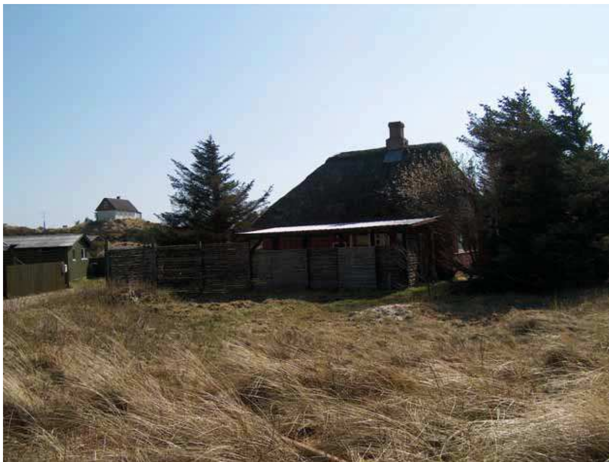
Foto nr. 70. Huset set fra krydset Sydvej/Rylevej. Man ser det skæmmende raftehegn og et halvtag, der er bygget på nordsiden af huset.
