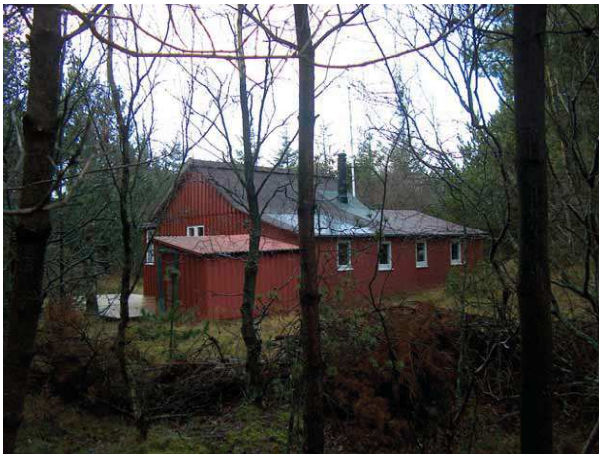
Foto nr. 10. Set fra skel mod Rylevej 8. Se også foto nr. 13 foran.
