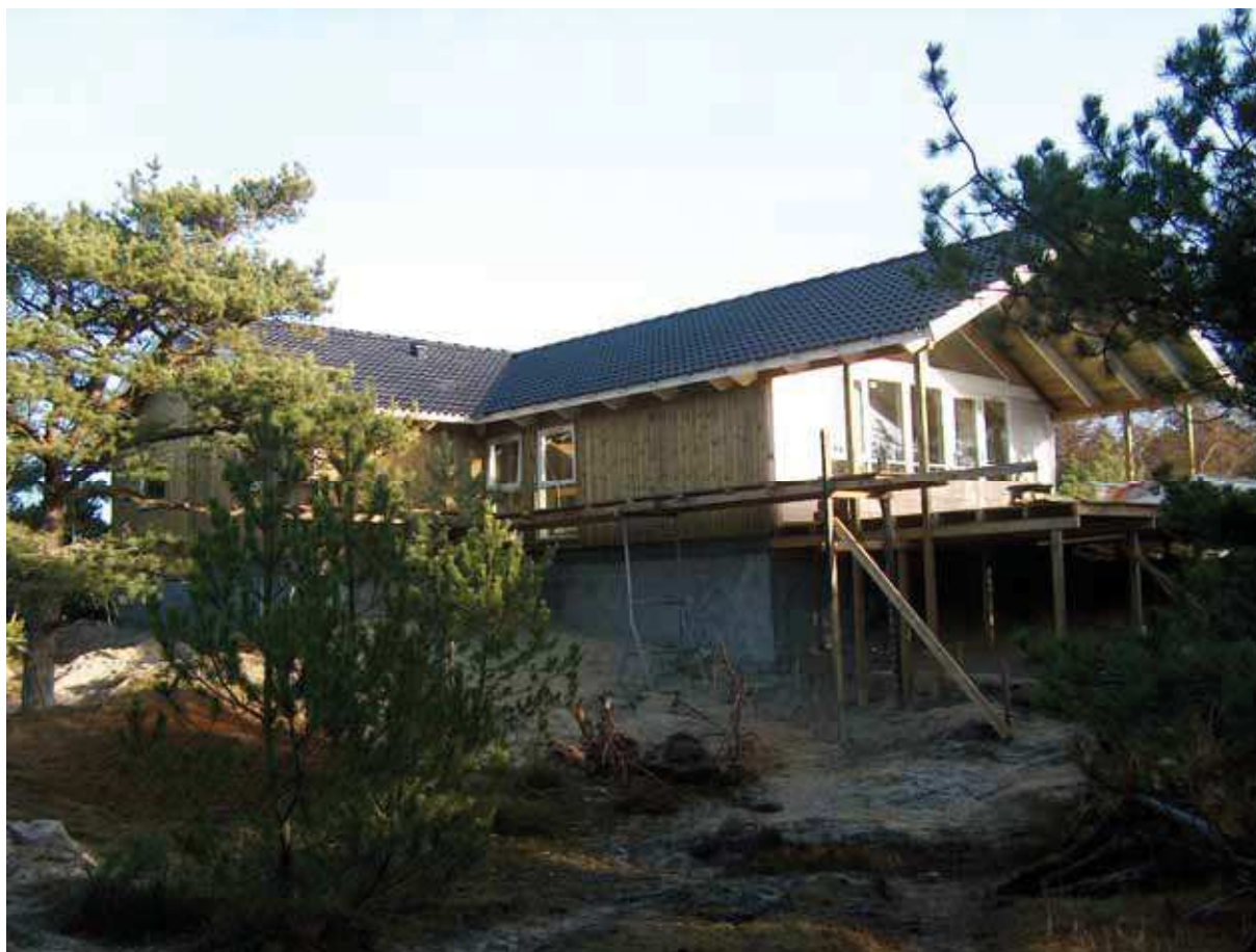
Foto nr. 44. Byggeriet set fra vejen. Bemærk den høje sokkel.
