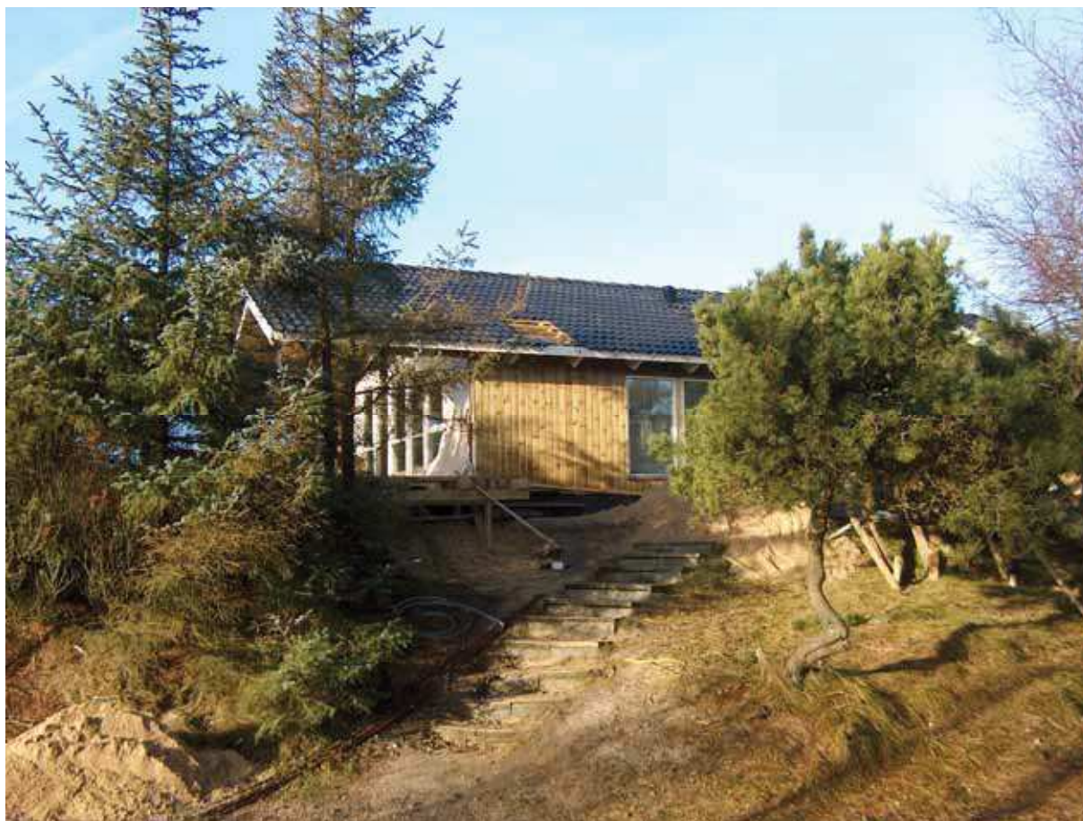
Foto nr. 44. Byggeriet set fra sydøst ved eksisterende anneks. Fra denne side falder byggeriet langt bedre ind i terrænet. Se dog de forrige sider.
