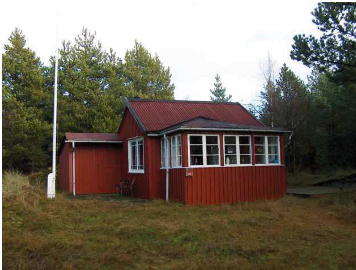
Foto nr. 13. Set fra Rylevej. Se også foto nr. 10 på næste side.
