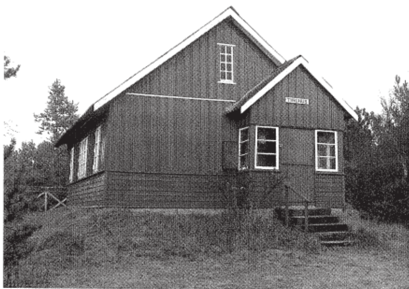
Figur 2: Rylevej 8 på 54 m 2 etageareal. Det bevaringsværdige hus er opført i 1927 og ombygget i 1995 (foto nr. 11).
