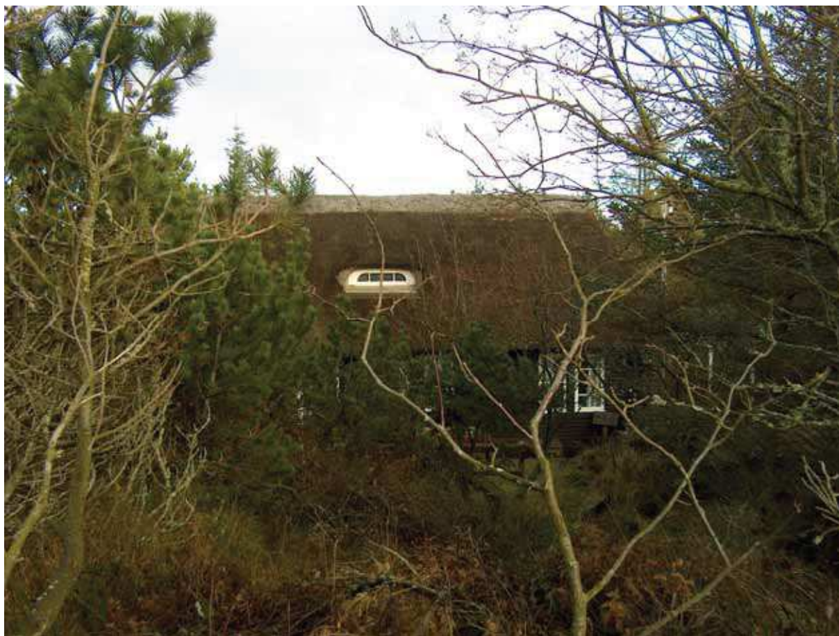
Foto nr. 22. Hovedhuset set fra klittop ved Vibevej 5. Se også foto nr. 23 – 25.
