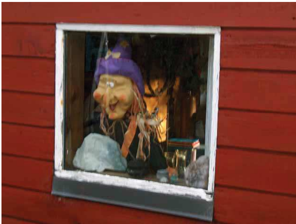
Foto nr. 23. Vinduesdetalje på udhus/anneks, der har klinklagt træbeklædning.
