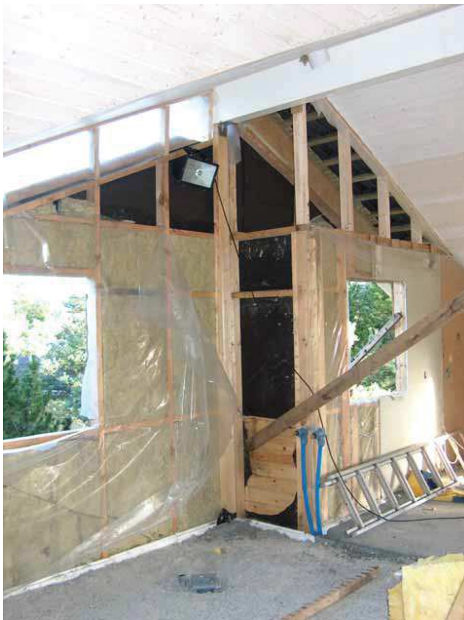
Foto nr. 43. Byggeriets nordlige gavl set indefra. Der er ikke meget at se af det oprindelige sommerhus. Se også foto nr. 40, 41, 42 og 44.
