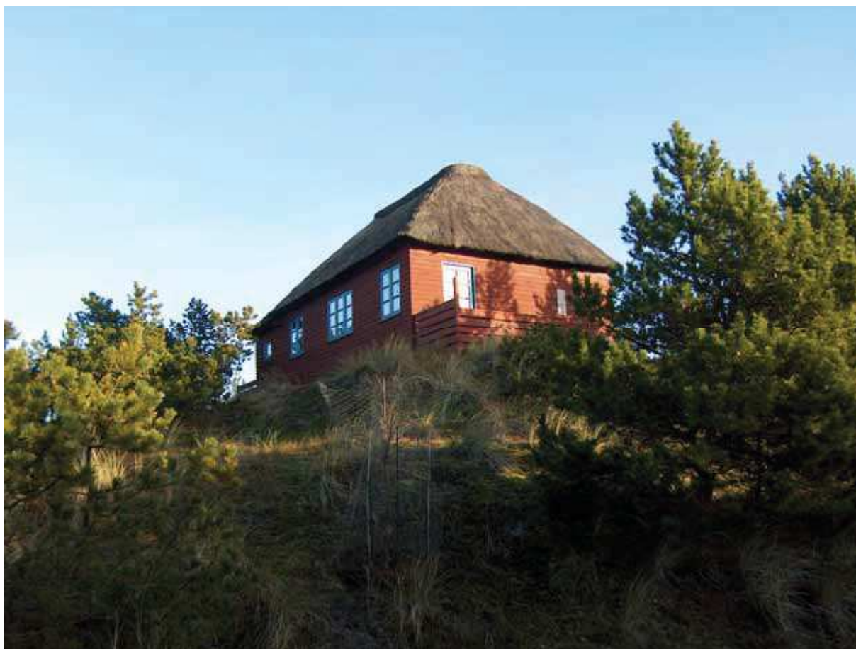
Foto nr. 31. Set fra bakketop på Uglevej ligger huset højt på en klittop. Se også fotonr. 32 og 34 på de følgende sider.
