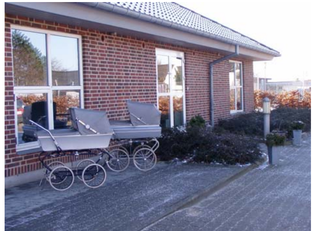
Indgangen til "Tumlehuset" på nordsiden af bygningen
