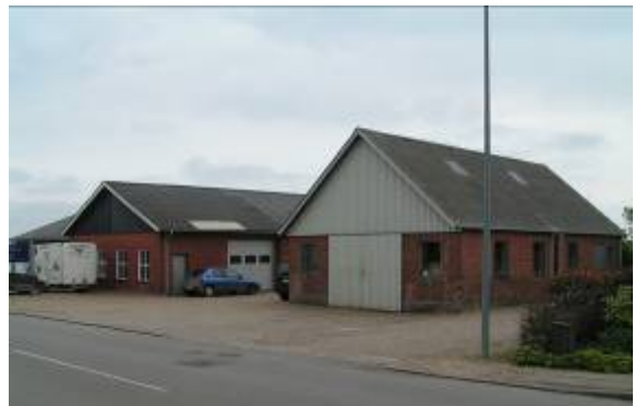
Figur 1. Kvong Smede- og Maskinforretning A/S set fra Langgade.
