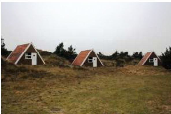
De eksisterende anneksbygninger ligger ved kliffoden.
