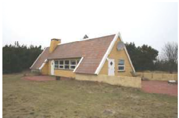
Det eksisterende sommerhus er opført i 50'erne.
