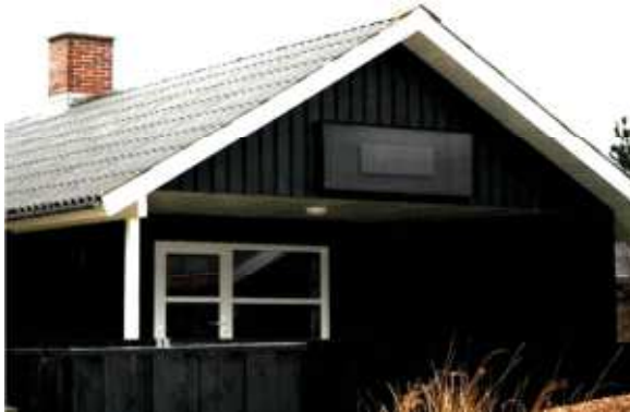
Solenergianlæg placeret i gavltrekanen
