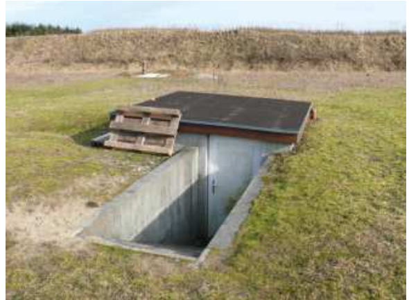
Nedgravet teknikhus til kastemaskine.
