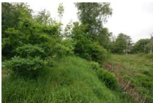
Omr. 8. Nedlagt baneskråning, set fra øst
