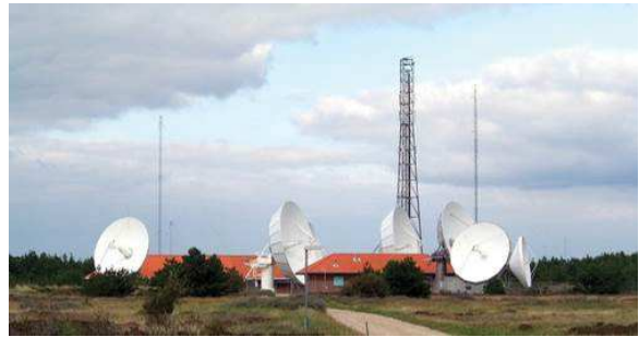
Blåvand Radio og antenneanlæg, syd for lokalplanområdet.
