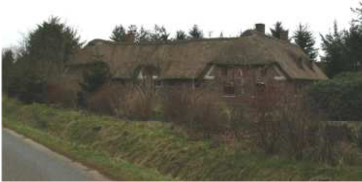
Beboelsesbygningens vestside set fra Hennebysvej.
