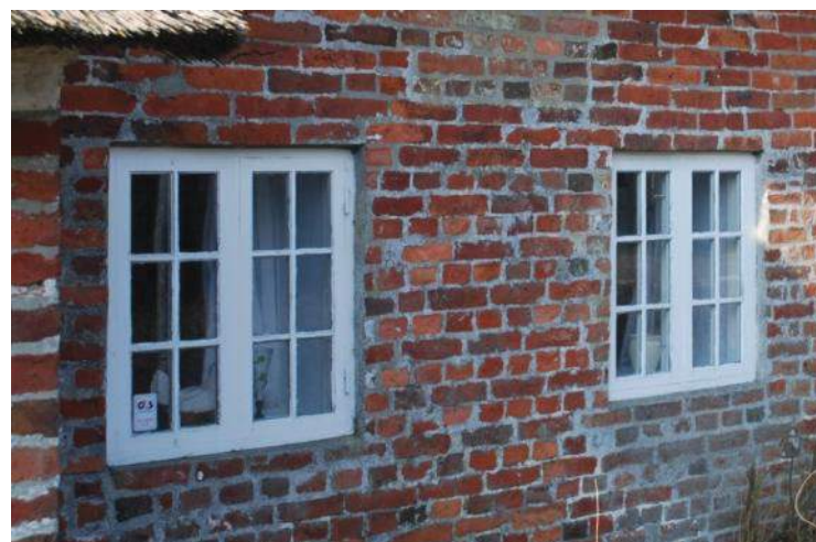
Eksempel på kitfalsvinduer fra området.
