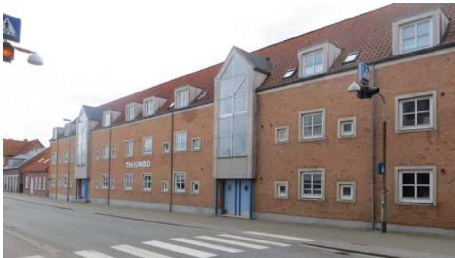
Billede 6; Storegade 9-11 i to etager med udnyttet tagetage.
