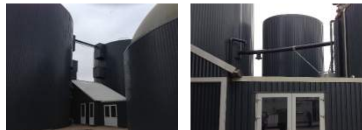
Figur 13 Eksempler på rørføring over terræn mellem to primær rådnetanke. Billedet stammer fra Hemmet Biogas.
