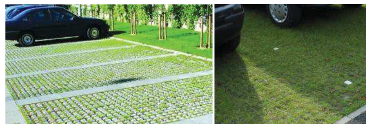
Eksempel på parkering på græsarmering i hhv. beton (t.v.) og plastic.
