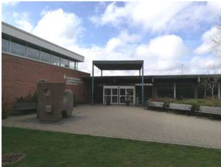
Billede 2: Det eksisterende indgangsparti til fritidscenteret.
