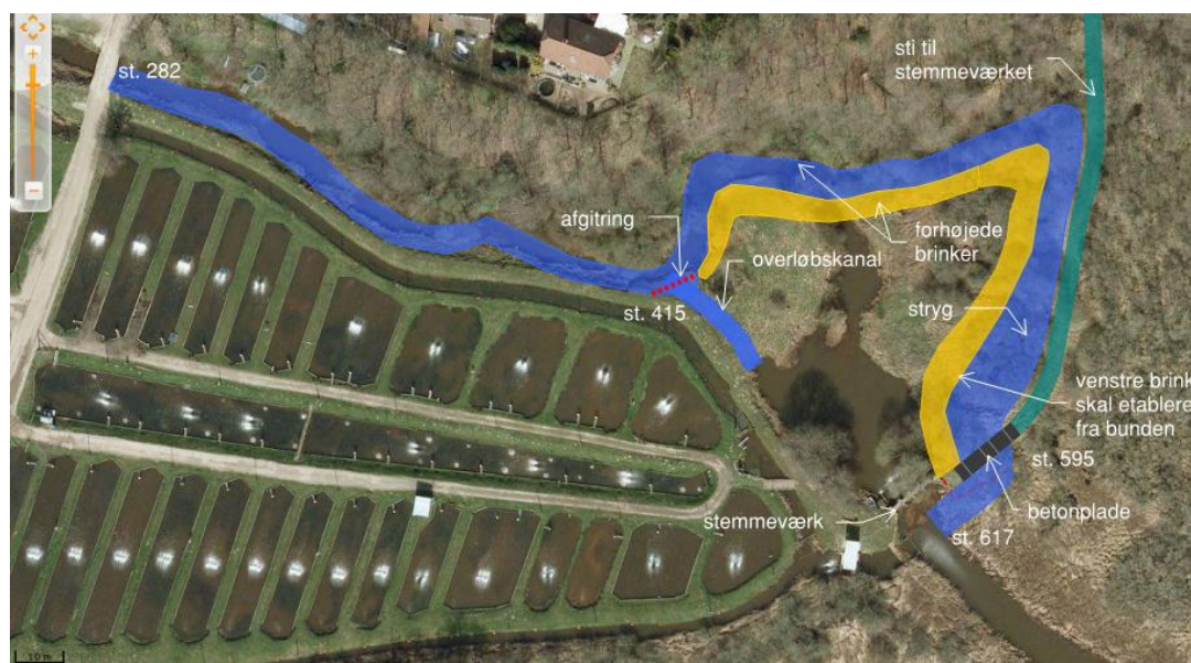
Fig. 10. Stryget etableres på den vestlige side af den eksisterende vold/sti. Hvor stryget skal krydse stien skal der etableres betonplade, da stien er eneste adgang til stemmeværket for maskiner.
