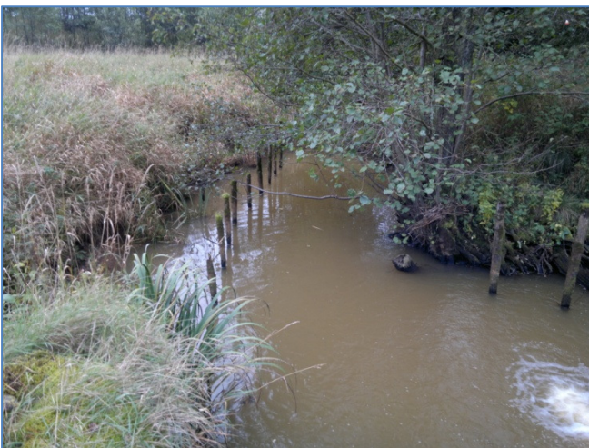
Fig. 3. Langs begge sider af vandløbet på en kort strækning nedstrøms stemmeværket er der gamle faskinepæle, der ikke længere har nogen funktion.
