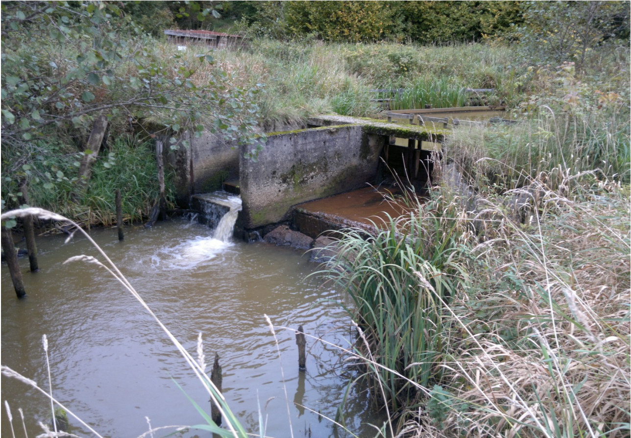
Fig. 2. Alt vandet afgives gennem stemmeværkets kammertrappe. Specielt nederste "trin" virker svært passabelt.
