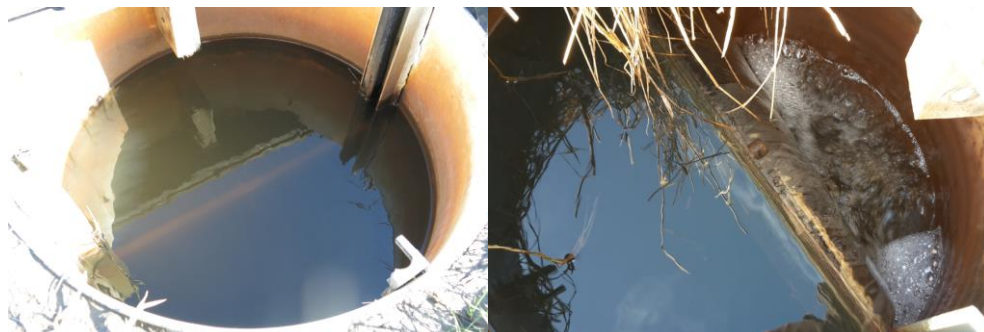
Figur 4-24. Stemmeværk. Tv. en højvandesituation. Th. er vandspejlet i recipientgrøften lavere end i den regulerede grøft.
