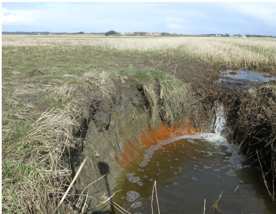
Figur 4-21. Udfældning af okker. Brinken er eroderet for nylig og en flade med okker er blevet synlig.
