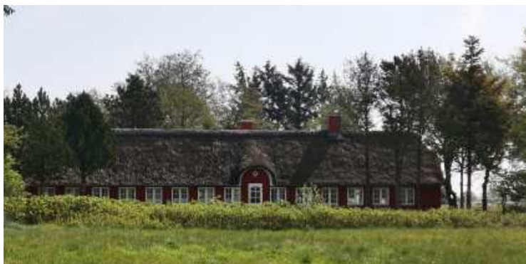
Billede 9: Sønderballevej 2, set fra Skallingevej.
