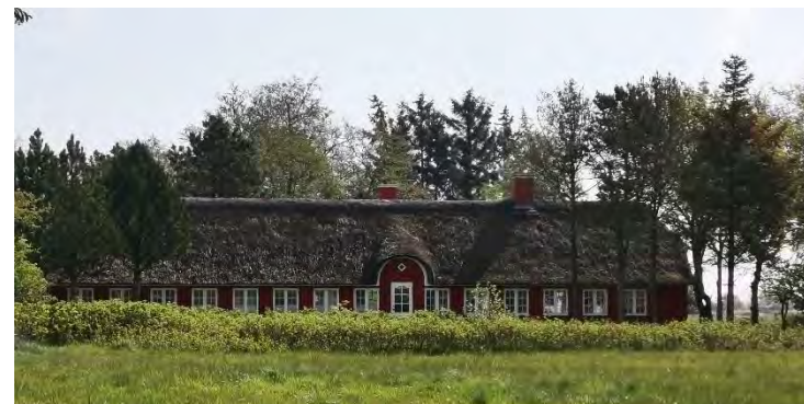
Billede 16: Sønderballevej 2, set fra Skallingevej.
