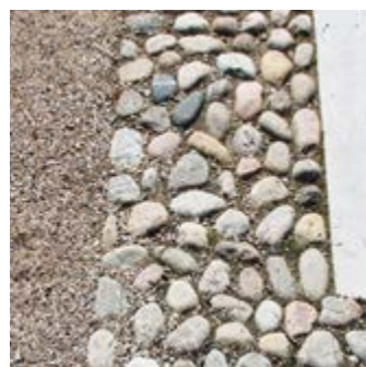
Køreareal p-pladser: Grus m. overgange til sten
