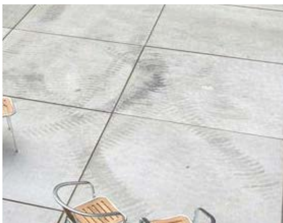
Insitustøbt beton på kørevej
