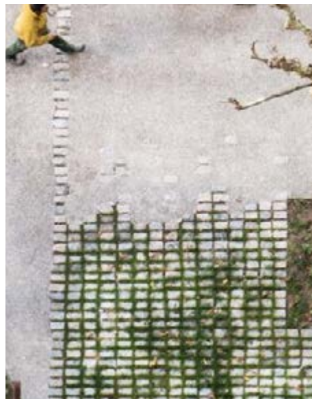
Hårde flader fører til permeable belægninger
