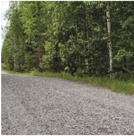
Grusbelægning på søgevej
