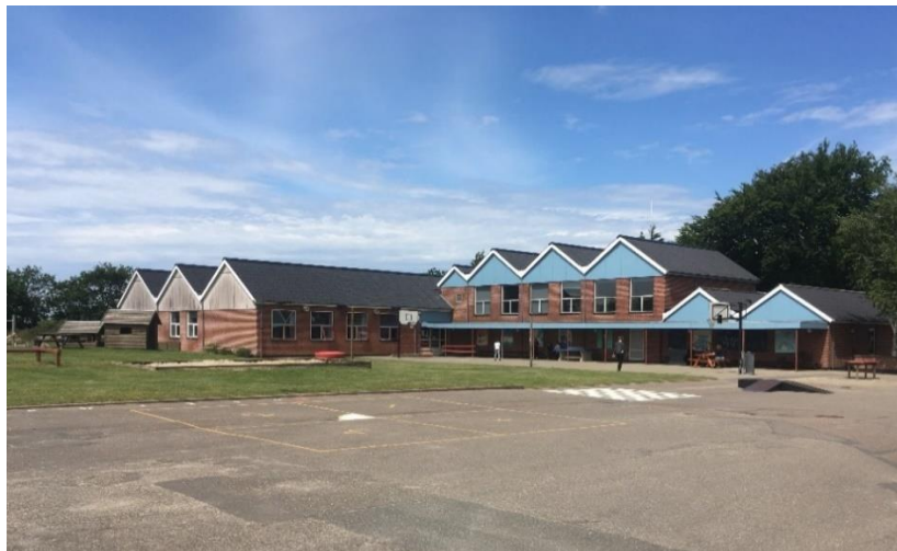
Den fritliggende bygning med skolegård og legeplads.
