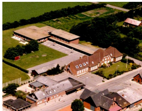
Luftfoto fra 1990'erne. Her ses hovedbygningen fra øst, hvor det fremgår hvad vilkårlige ovenlysvinduer gør for den arkitektoniske værdi ved hovedbygningen.
