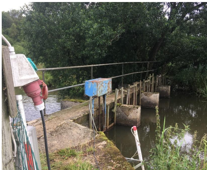
Figur 5 Stemmeværket i Alslev Å. Der nedsættes en frontvæg af stål foran stemmeværket og vandløbet fyldes op frem til stryg indløbet.
