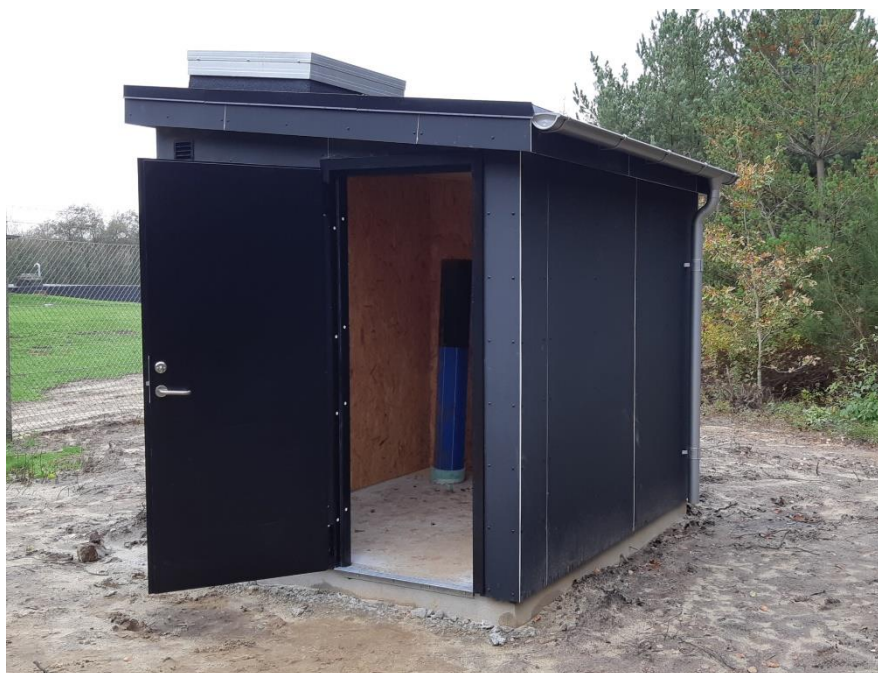
Figur 5.6: Et eksempel på udformning af et boringshus før installation af maskinkomponenter.
