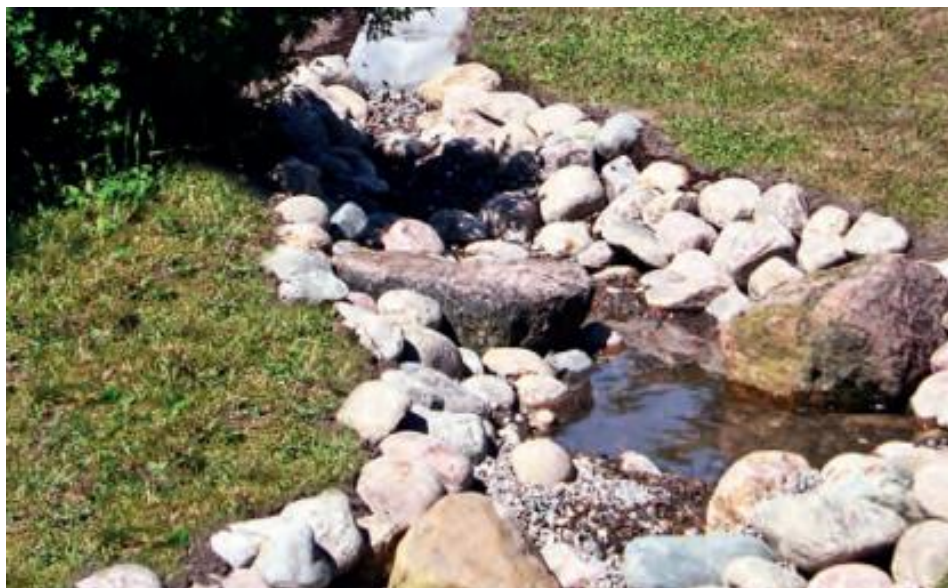
Figur 4.14: Grussætning ved udløb af pumpeledning til vandløbet. Grusætningen etableres på brinken. Eksempel.
