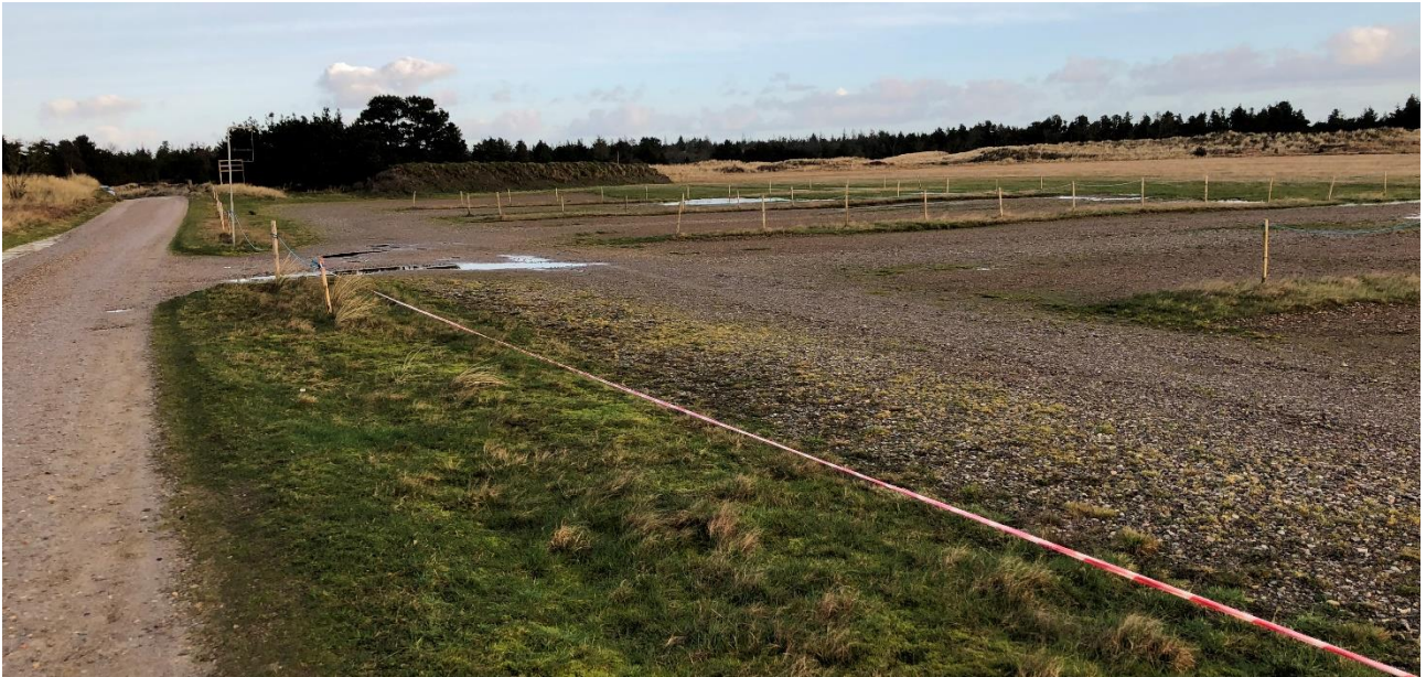
Figur 5. Eksisterende midlertidige p-plads, set mod nord.
