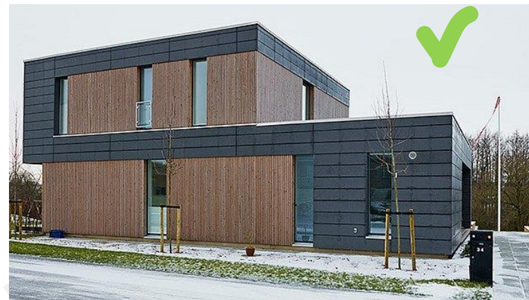
Eksempel på fibercement brugt som facadebeklædning i kombination med træbeklædning.
