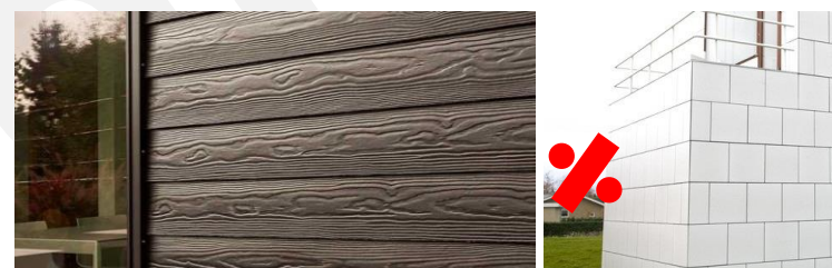
Eksempel på fibercementbeklædning, der ikke må anvendes inden for lokalplanens område.
