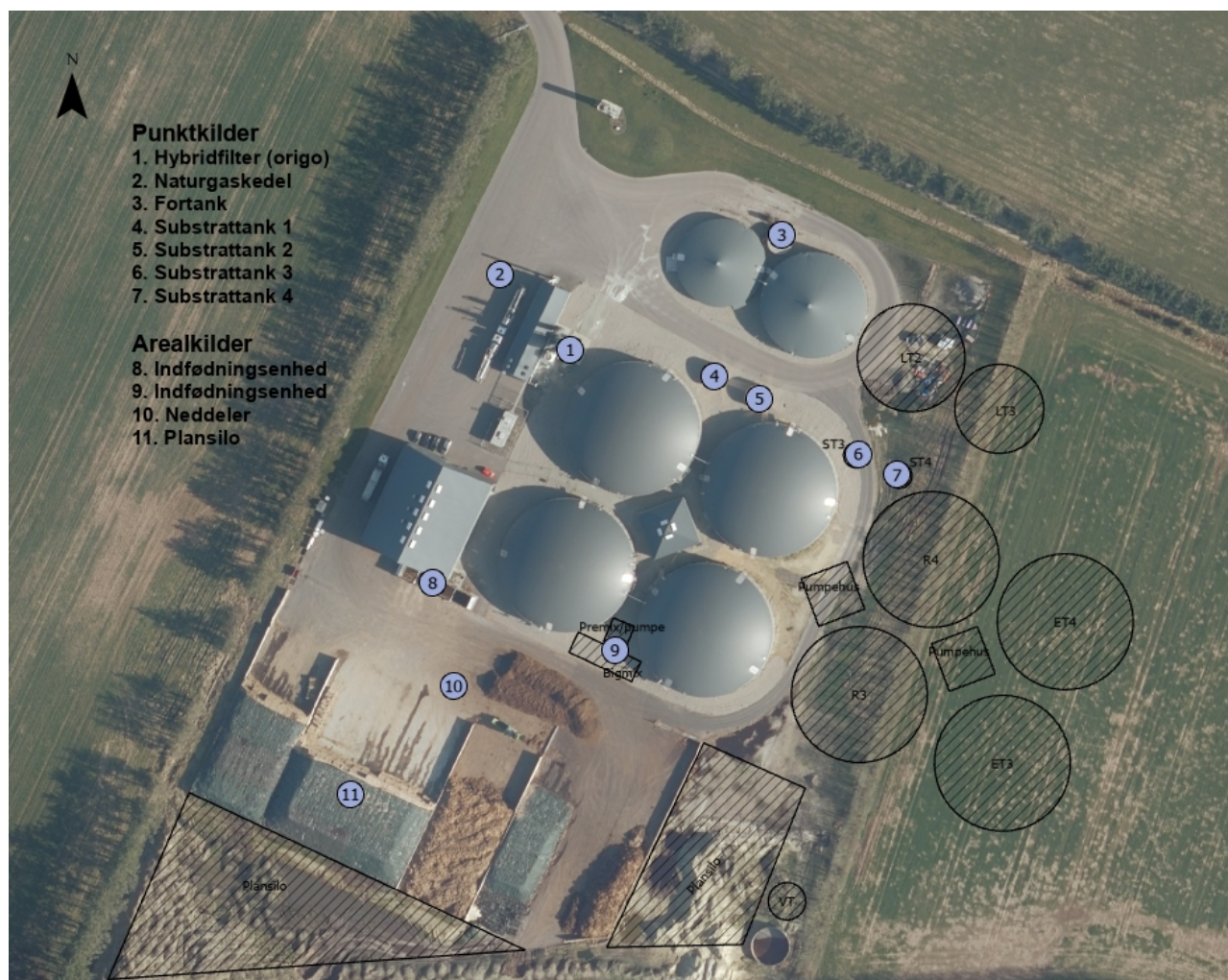
Figur 14; Oversigt over lugtkilder hos Outrup Biogas ApS
