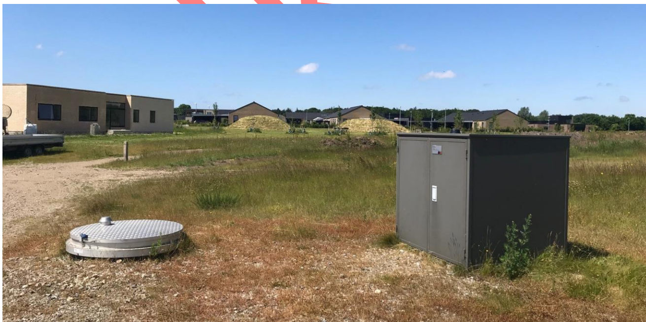
Figur 4. Foto af nyligt etableret pumpestation med kombineret el- og ventilskab, som forventes anvendt i nærværende projekt.
