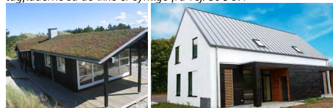
Eksempel på sedum og tage med stålplader.
