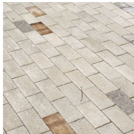
Kombineret beton og teglbelægning
