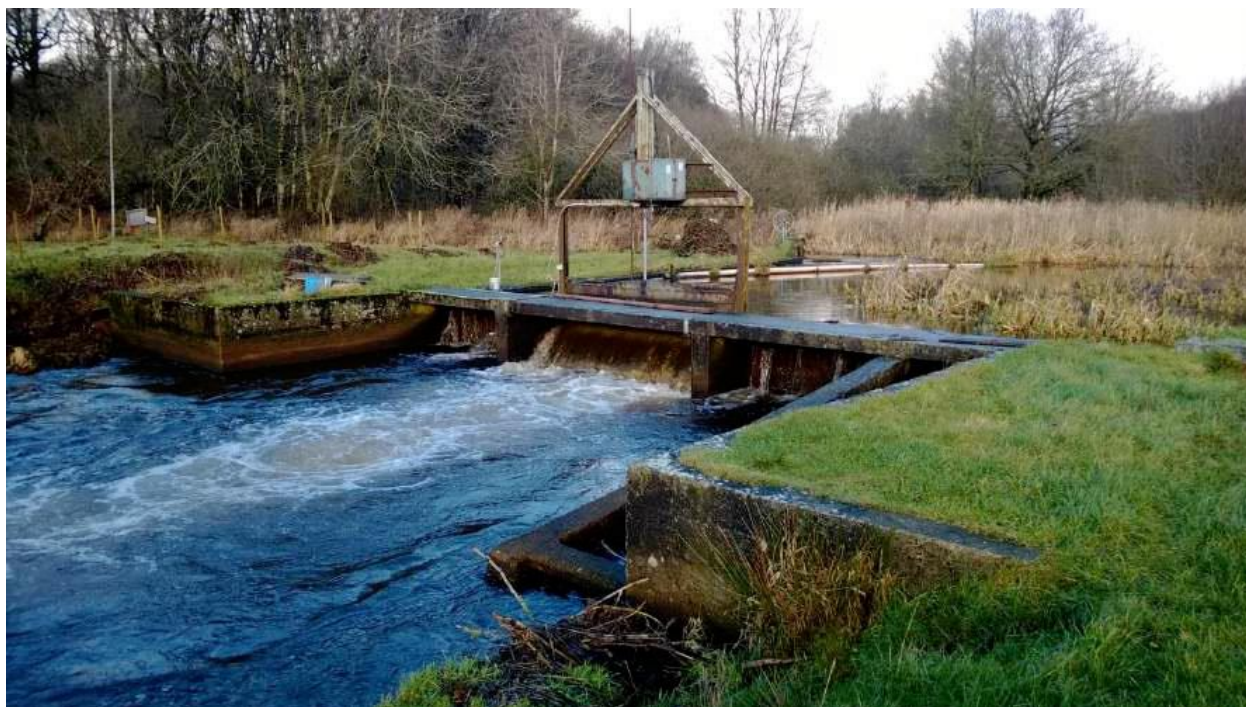
Figur 2 Stemmeværket, fisketrappen og i baggrunden indløbsbygværket
